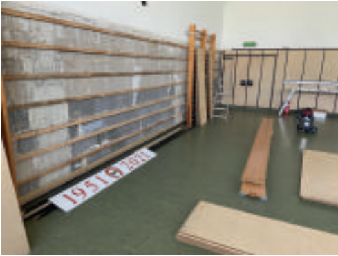
Die Halle oben bekam an der FTG-Seite die Wandplatten gegen neue Holzplatten ausgetauscht. Alle anderen Wände wurden abmontiert, mit frischer Farbe mintgrün gestrichen und dann wieder angebracht.
