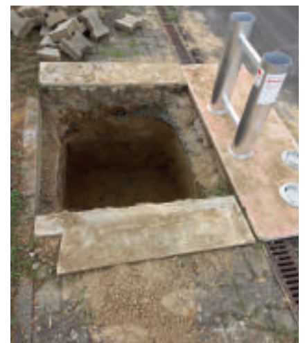
Nur um die Löcher dann wieder - mit den Ständerhülsen - mit Beton vollfüllen zu lassen. Das hält ewig!
