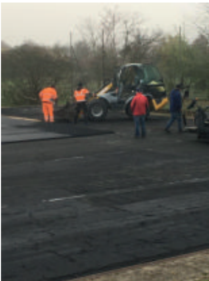
Alter Belag ab und neuer Asphalt drauf. Das gibt einen neuen festen Untergrund - auch beim Hinfallen.
