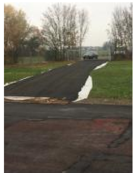
Mit schwerem Gerät wurde der Freiplatz mit einer Asphaltsschicht überzogen
